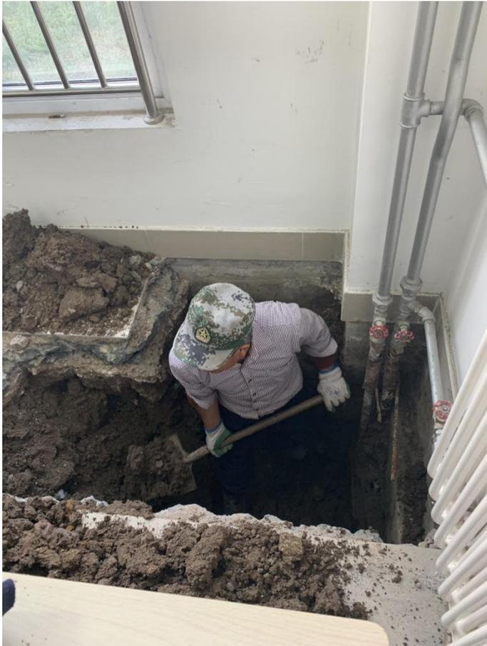
和维修工作人员积极努力的排查漏点，现查明 4 处漏点，分别在 104、106 及大厅位置。现正在加紧抢修中，已保证尽早恢复 M7 教学楼的供暖。
