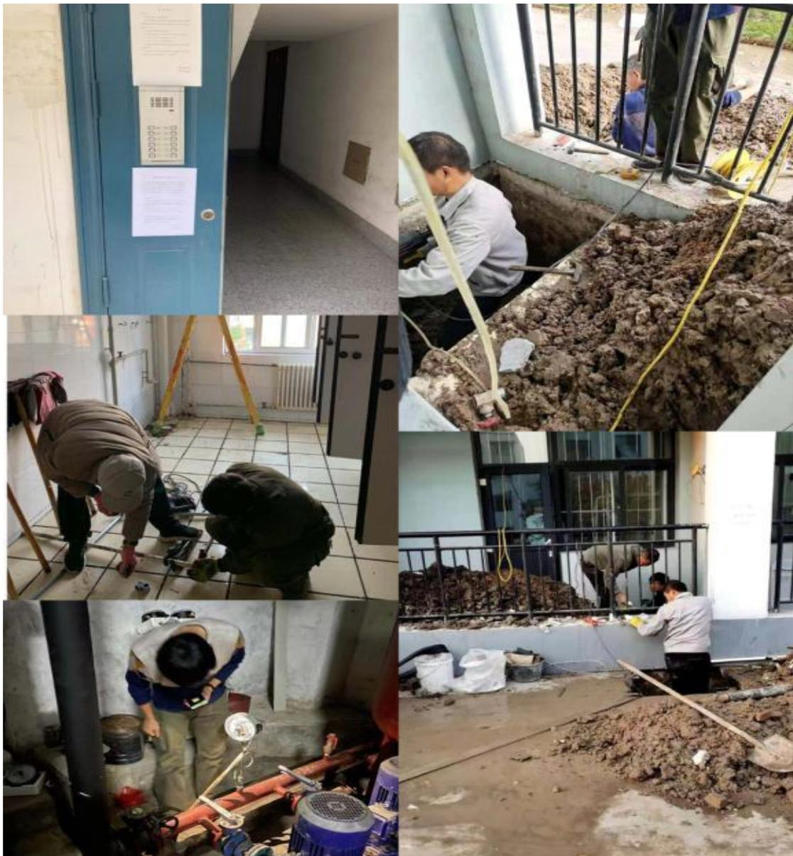
后勤基建办公室首先对校区内供暖管网、换热站等整个供热系统进行了全方位的检查、维修，以确保设施设备完好。在保证供热系统可以正常运行之后自 11 月 3 日开始分区域、分时段进行注水试压工作。在试水打压前，后勤基建办公室及时张贴通知提醒师生宿舍及教室、办公室内确保留人，以便发生泄漏现象及时报修。由于校区内的供暖管道使用年限较长，管道老化腐蚀严重，管壁很薄，有的管道用手轻轻一碰就会破碎，给维修造成了极大困难，部分无法维修的管道只能采取局部割除更换的办法，从而导致维修时间延长。很多时候为了查找漏点，工作人员需要顺着管路一点一点地排查，自供暖准备至今工作人员一直采取白+黑，5+2 的工作时间，至今已维修漏水 50 余处。
